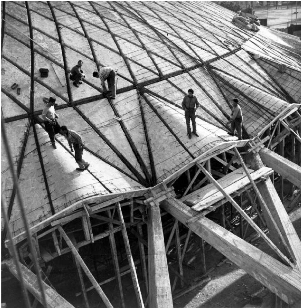
Palazzetto dello sport in costruzione, Roma , Pier Luigi Nervi, 1956-1957
